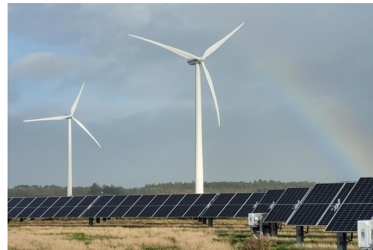
▲ EE社が開発したデンマーク・ホルメン所在の発電設備
