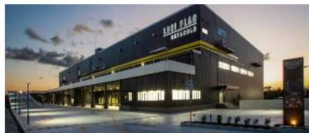
▲ マルチ型冷凍冷蔵倉庫 「LOGI FLAG DRY & COLD 福岡古賀Ⅰ」
