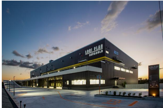
▲ マルチ型冷凍冷蔵倉庫 「LOGI FLAG DRY & COLD 福岡古賀 I」
