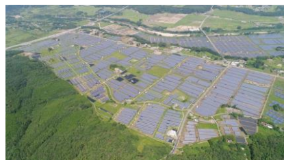
浪江町谷津田地区メガソーラー発電所
