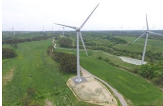
横浜町雲雀平風力発電所(青森県)
