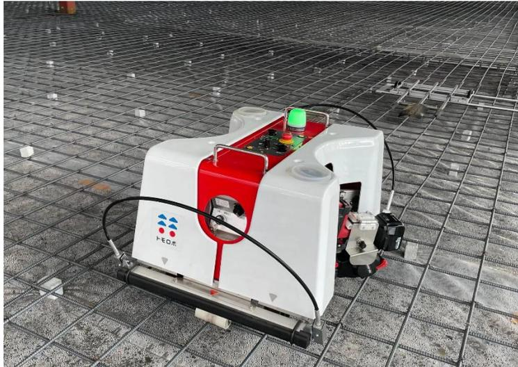
建ロボテック 鉄筋結束トモロボ
