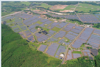
浪江町谷津田地区 メガソーラー発電所（福島県）
