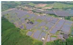
浪江町谷津田地区 メガソーラー発電所 (福島県)
