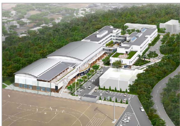
銚子市立銚子高等学校施設整備等事業 (千葉県銚子市)
