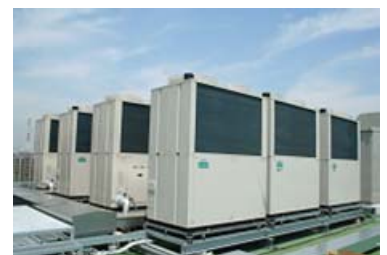
ESCO事業を導入された千代田化工建設株式会社様の本社社屋に設置されたガスヒートポンプ空調機
