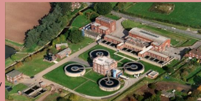
SS社が保有・ 運営するSeedy Mill浄水場
