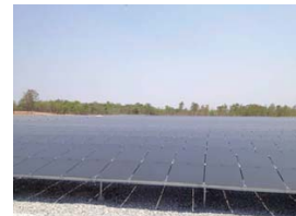
建設中の太陽光発電プラント (コンケン県チュンペー郡)
