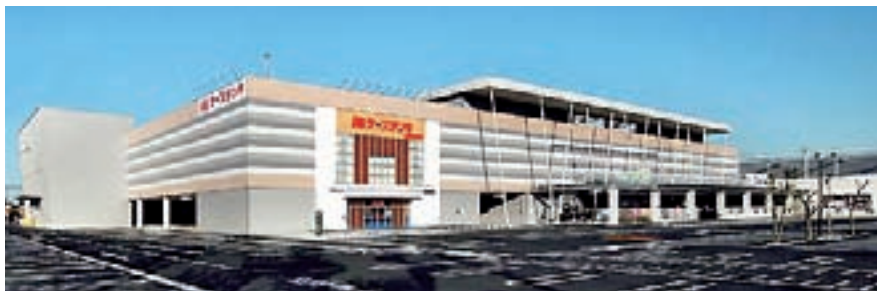
西大寺グリーンテラス（岡山県）
