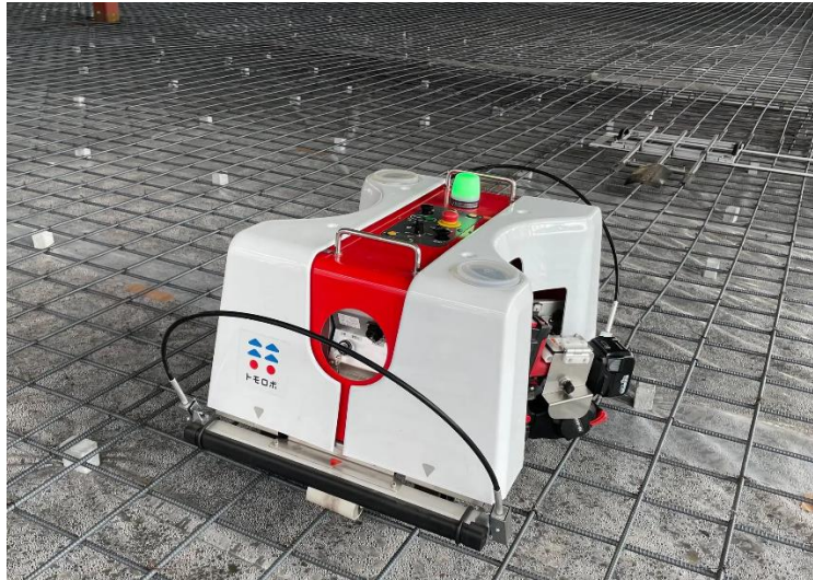
建ロボテック 鉄筋結束トモロボ
