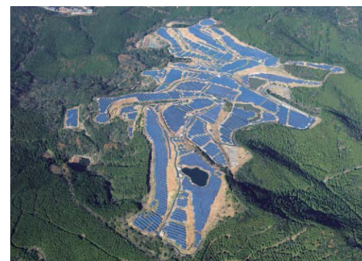
「サンシャインエナジー湧水」太陽光発電所の全景
