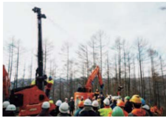
作業中の様子
