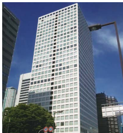
環境改修工事を実施する築42年のオフィスビル「大阪国際ビルディング」
