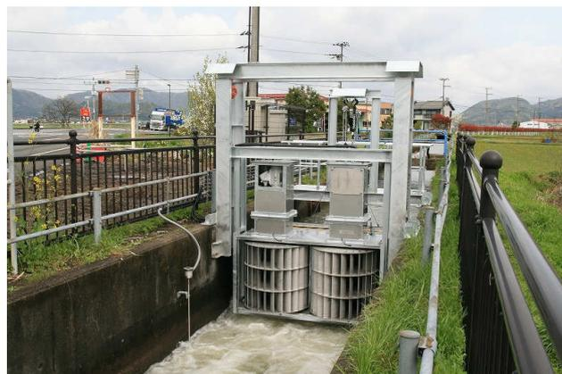
10号落差工（10kW規模発電）
