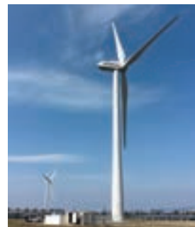
エネ・シード北九州風力発電所
