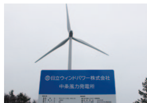
中条風力発電所のHTW2.0-86初号機
