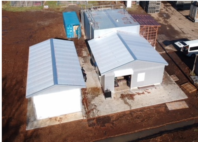
発電所の全景
