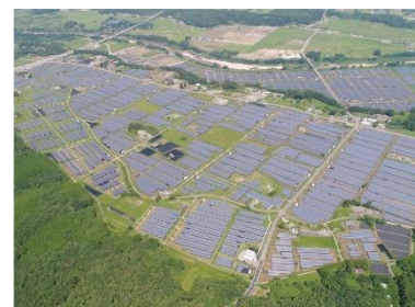
▲ 浪江町谷津田地区メガソーラー発電所 (福島県)
