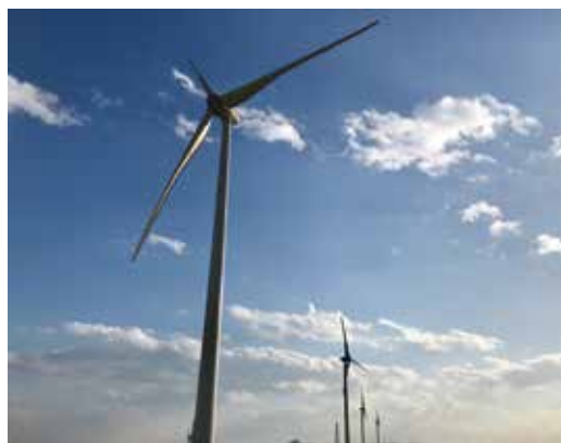
「万葉の里風力発電所（福島県南相馬市）」が竣工
