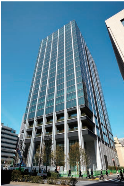
環境配慮型・高機能オフィスビル「西新橋スクエア」外観
