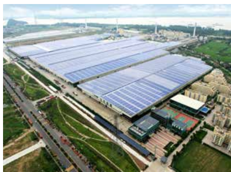
当社がシンジケートローンを組成した、太陽光発電事業者の 1,034MW 規模の太陽光発電
